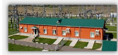
Общеподстанционный пункт управления (ОПУ)
